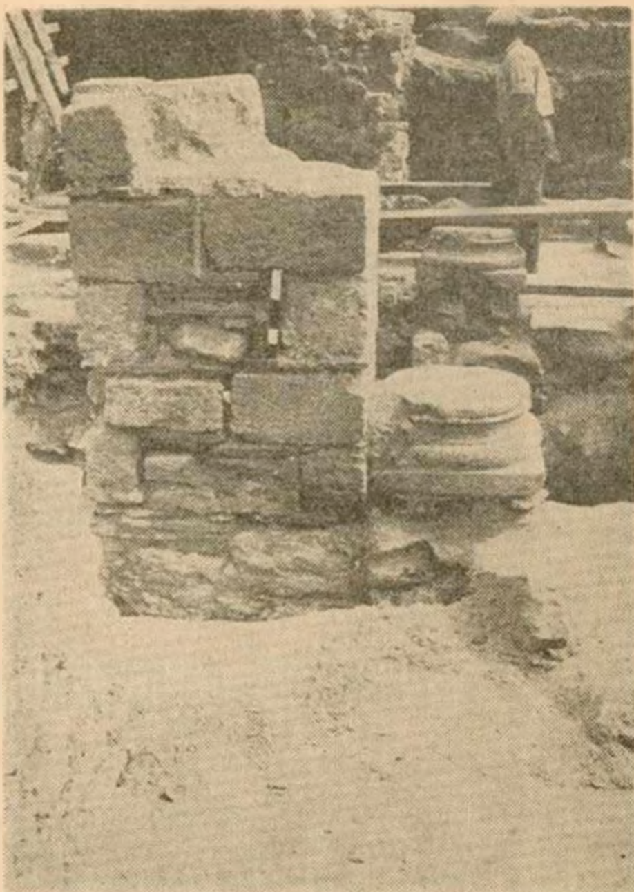
Ἐνας ἀπὸ τοὺς πεσοὺς τοῦ Ἱεροῦ. Χαρακτηριστικὸ τὸ πλινθοπεριζλιστο σύστημα.
